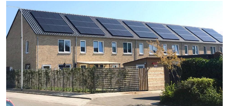
Figuur 18: Een voorbeeld van zonnepanelen op het dak van rijwoningen in Groningen 5 .
