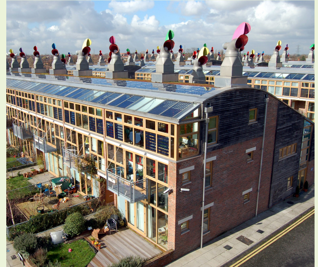
BedZED, duurzame woningen in Londen met een moderne interpretatie van de windvanger voor verkoeling.
