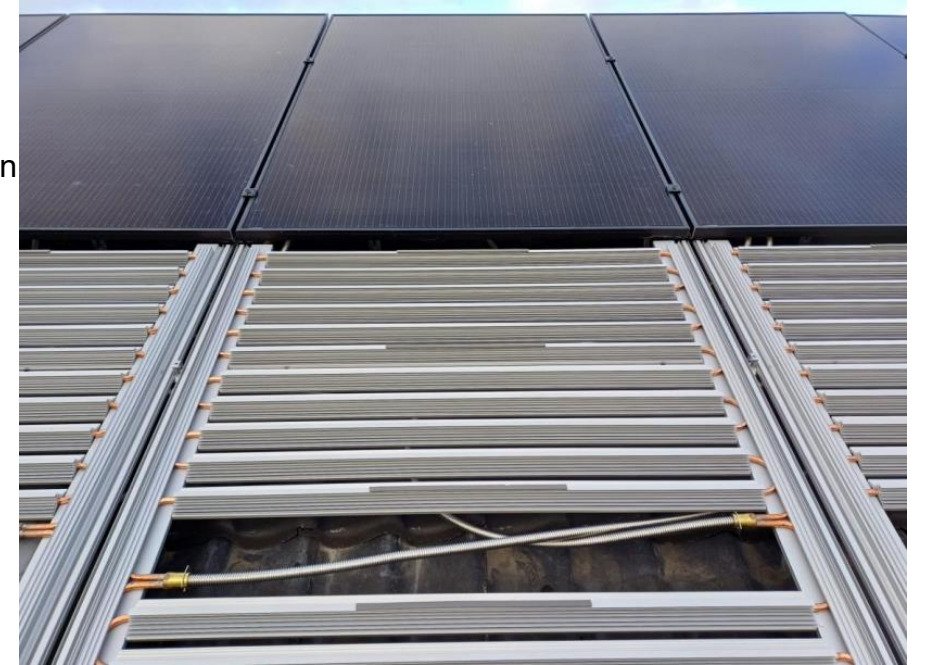
Figuur 14. PVT systeem dat op een dak wordt geïnstalleerd 2 .
