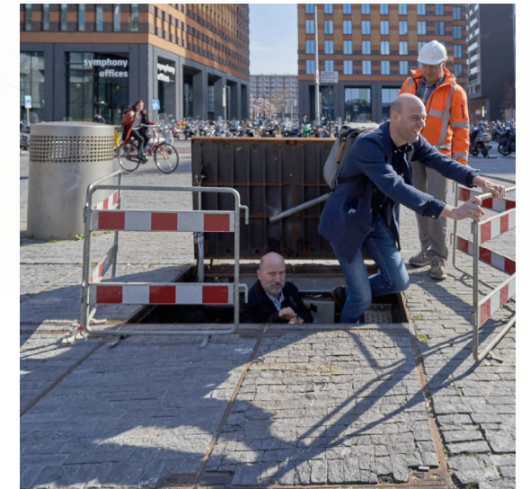
Integrale leidingentunnel, Zuidas, Amsterdam
