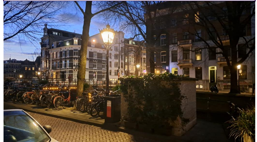
Foto Middenspanningsruimte aan de Leidsekade die het gebied uit de casus voedt. Het verzorgingsgebied van deze MSR beslaat enkele honderden huishoudens in de omgeving, en zal overbelast raken wanneer de verwarmingsopgave resulteert in een grote groei in elektriciteitsvraag.
